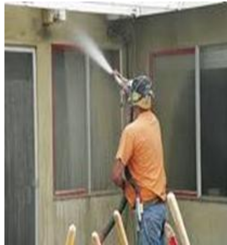
تصویر شماره 16: تصاویر عملیات سندبلاستینگ
