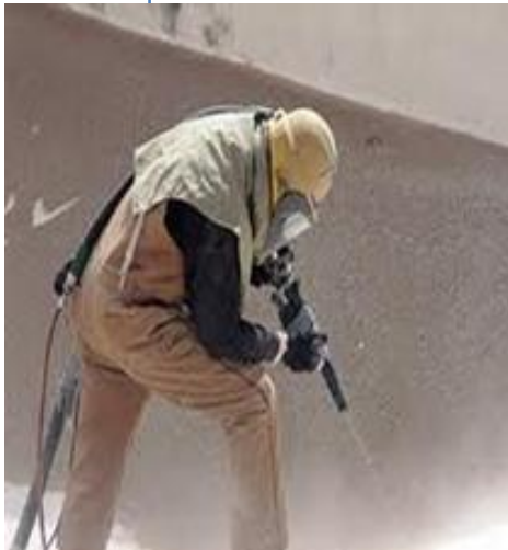
تصویر شماره 16: تصاویر عملیات سندبلاستینگ
