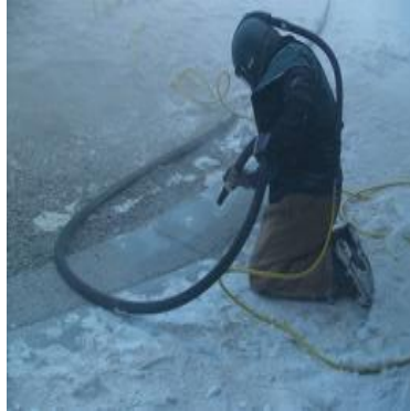
تصویر شماره 51: عملیات سندبلاستینگ
