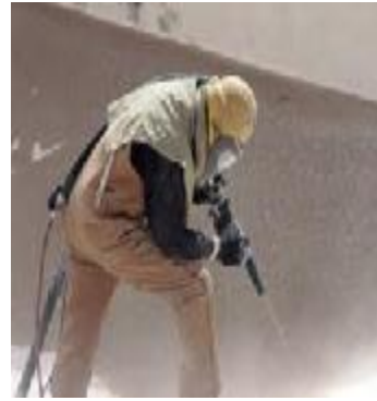
تصویر شماره 51: عملیات سندبلاستینگ
